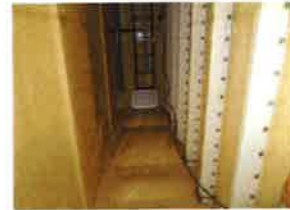
施工前のタンク内
